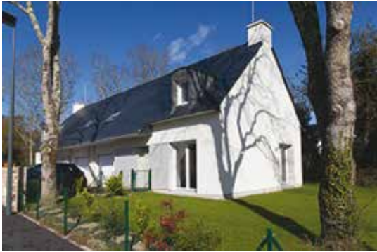
Réalisation à Combrit Sainte-Marine.
